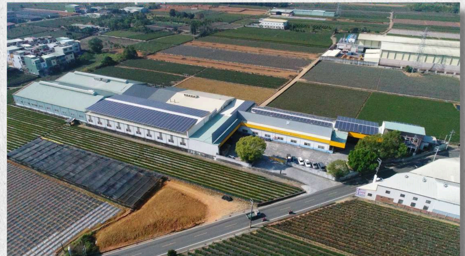
南投總廠 太陽能版設置
